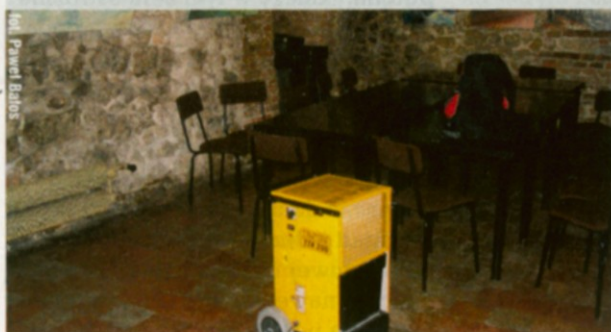
↑ Osuszacz kondensacyjny ustawiono w największym z trzech połączonych pomieszczeń piwnicy
