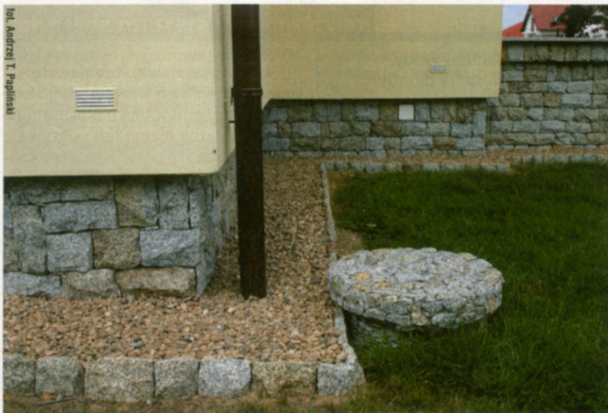
↑ Dobrym rozwiązaniem jest cokół cofnięty w stosunku do lica ściany, obłożony okładziną odporną na działanie deszczu, oraz prawidłowo wykonana opaska wokół niego
