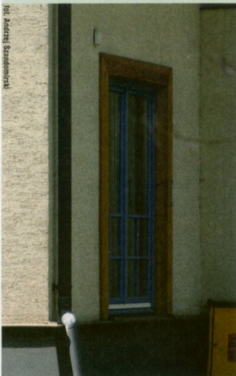
↑ Dobrym rozwiązaniem jest cokół cofnięty w stosunku do lica ściany, obłożony okładziną odporną na działanie deszczu, oraz prawidłowo wykonana opaska wokół niego
